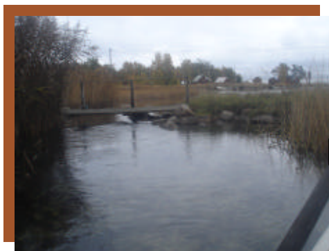
Före åtgärd, sundet är nästan helt igensatt av stenbron och vassen.
