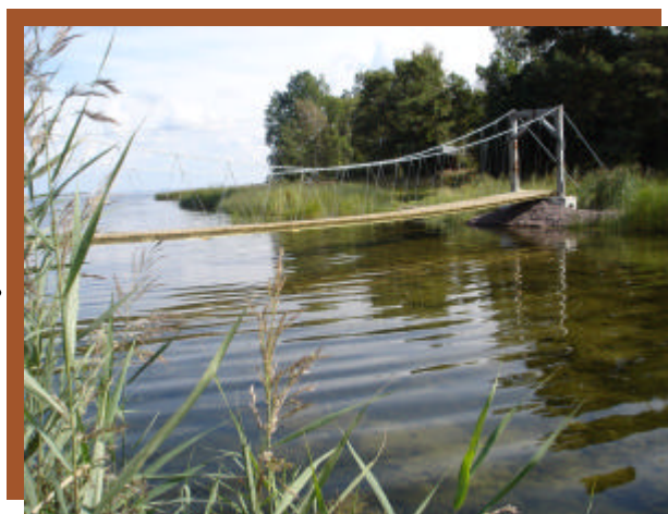
Efter åtgärd, genomströmningen är betydligt förbättrad. Stenbron är bortgrävd och ersatt med en hängbro där syreriktvattnet kan strömma fritt in till viken.
