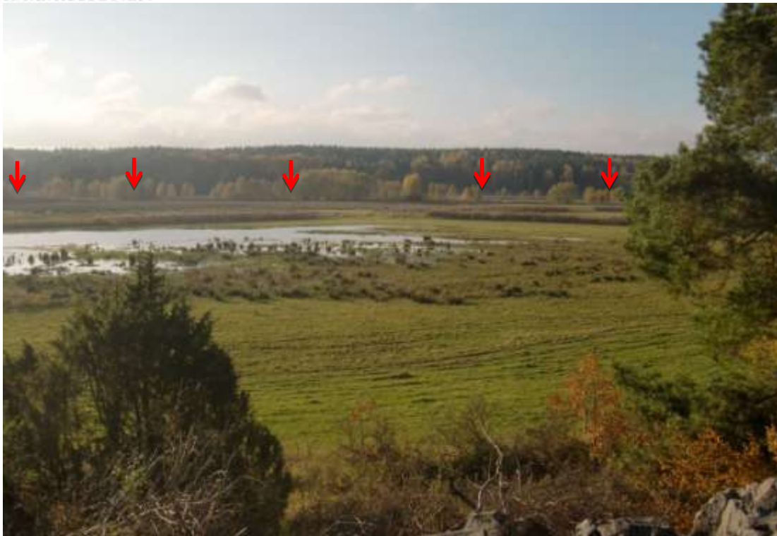
Figur 1. Fotot visar vy över delar av projektområdet vid högvatten i oktober 2011. Vattenspegeln visar en mindre yta inom projektområdet där våtmarksyta redan skapats i anslutning till ett dräneringsdike. Röda pilar visar Loftaåns sträckning centralt i dalgången med typisk rad av lövträd på de sedan dikningen upplagda rensmassorna.
