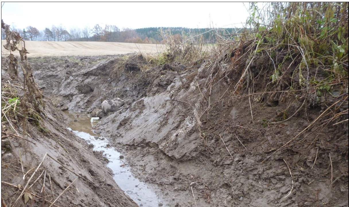
Figur 6. Exempel på ett nyligen rensat dike i anslutning till jordbruksmark. Notera avsaknaden av skyddszon längs diket och att växtlighet saknas på slänterna. Vid nästkommande större nederbörd och högflöde kommer ytavrinning från omkringliggande mark och erosion längs slänterna leda till att stora mängder uppgrumlat material och näringsämnen transporteras nedströms (foto: Cecilia Larsson).
