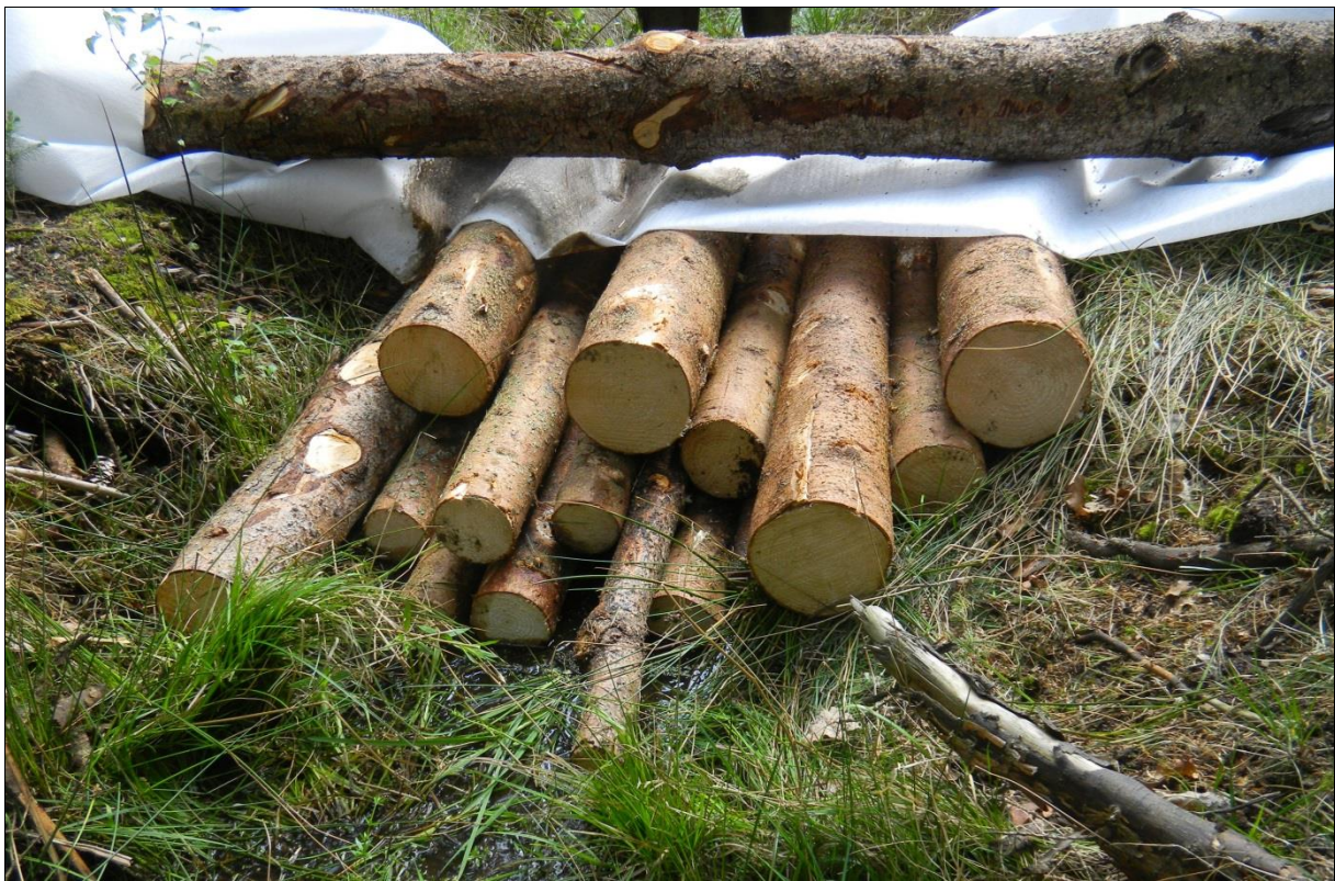
Figur 20. Proppning av skogsdike vid Fastlycke sommaren 2012 (foto: Torsås kommun).
