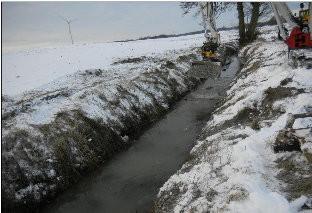
Figur 21. Anläggning av kalkdike vid Kroka vintern 2013 (foto: Torsås kommun).
