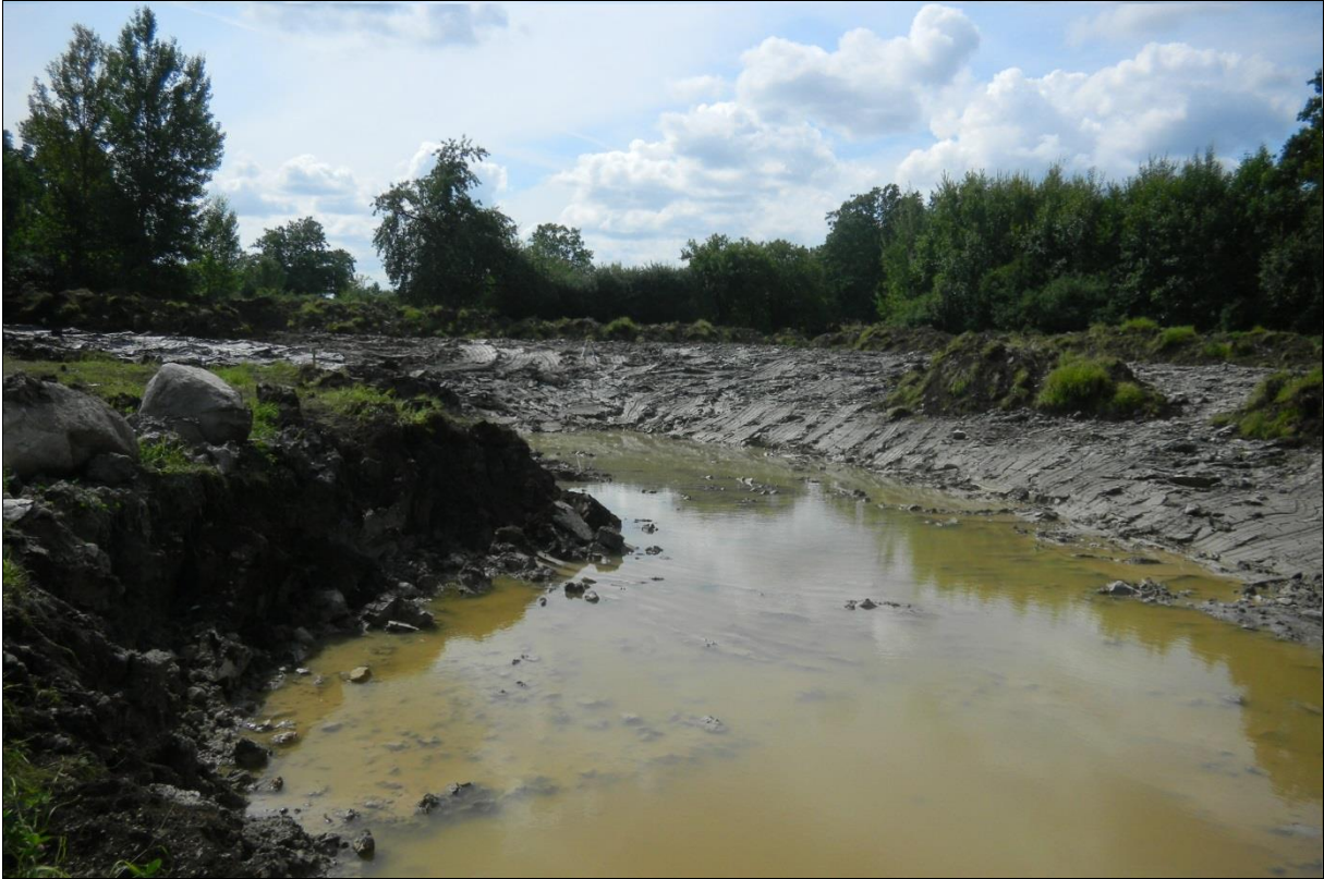
Figur 25. Pågående anläggning av översvänningsområde vid Sloalycke sommaren 2012, kart-nr: 41 (foto: Torsås kommun).
