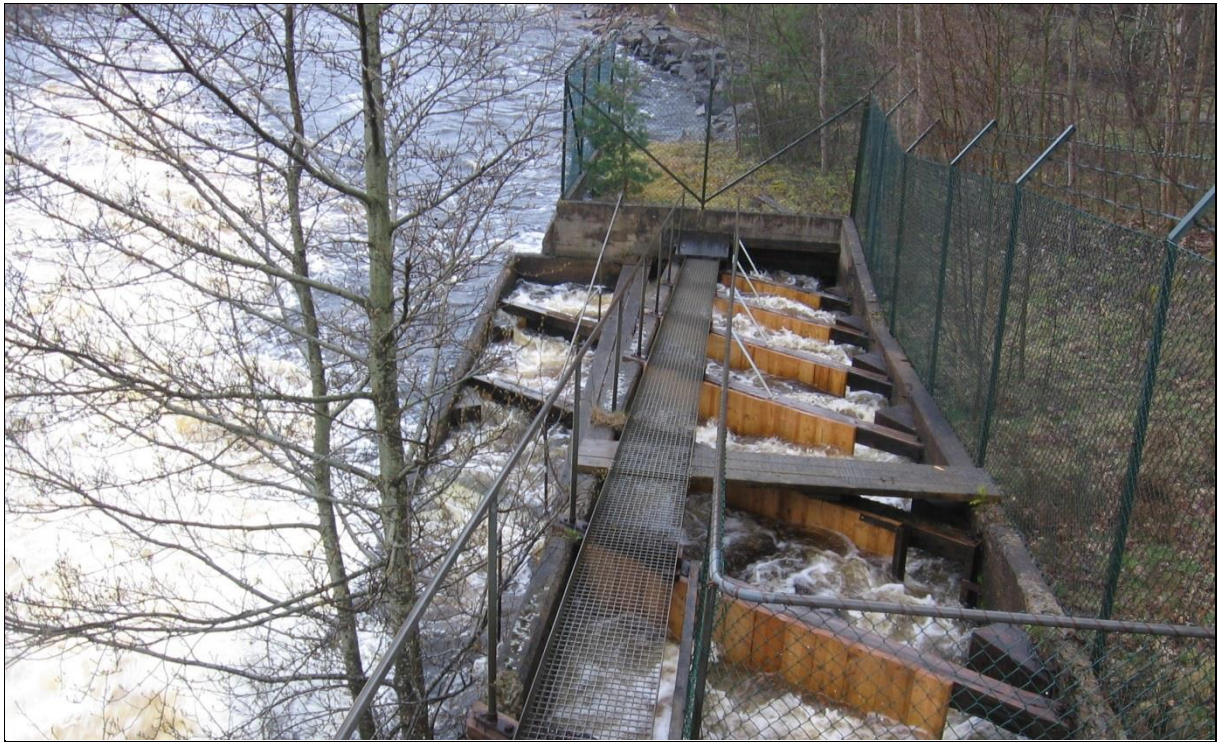
Figur 17. En så kallad slitsränna vid Marieberg i Mörrumsån (foto: Niklas Nilsson).
