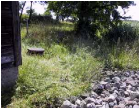
Pumpbrunn vid Påbonäs.
