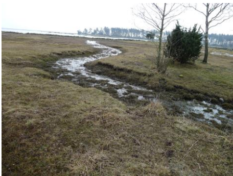
Bild: Delprojekt 8:1 Damm med vattenförande dike
