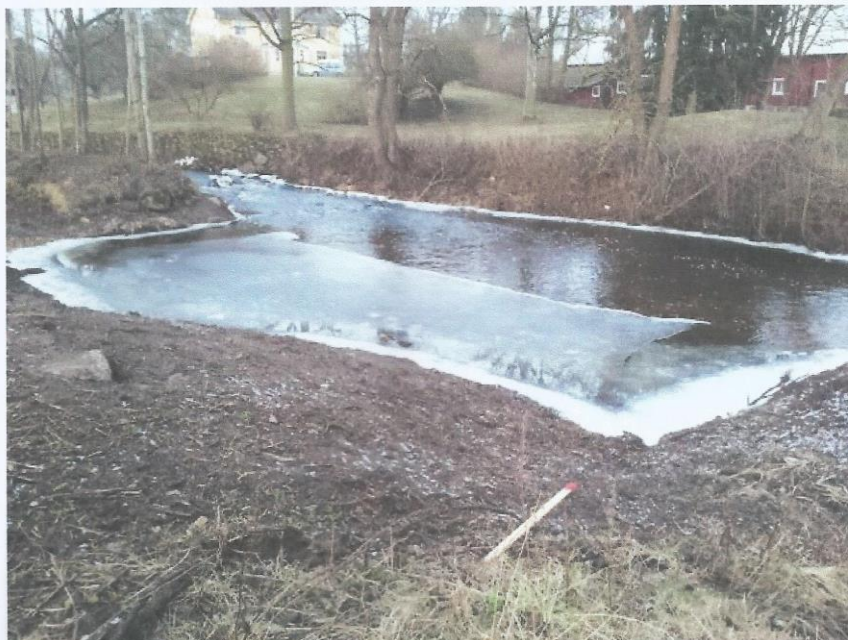
Den nygrävda fosfordammen i Snärjebäcken samlar fosforrikt sediment och förhindrar att näringsämnen hamnar i Östersjön (bilden tagen i februari 2016)
