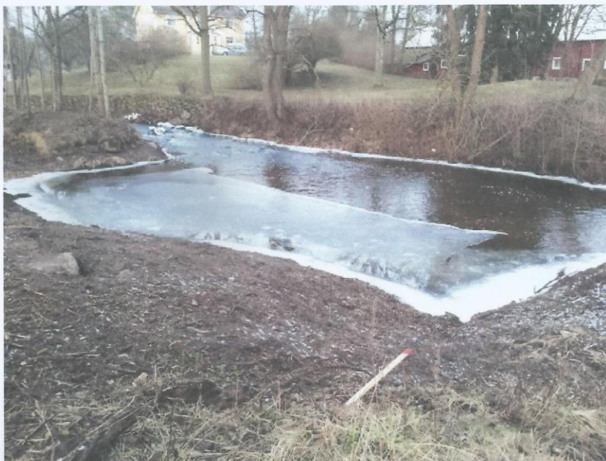
Den nygrävda fosfordammen i Snärjebäcken samlar fosforrikt sediment och förhindrar att näringsämnen hamnar i Östersjön (bilden tagen i februari 2016)
