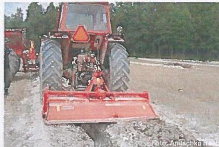
Inblandning av struktorkalk i återfyllnadsjorden vid täckdikning på lerjordar förbättrar genomsläppligheten och minskar fosforförlusterna.
