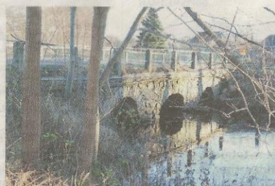
Åtgärder ska genomföras vid Österbro.
