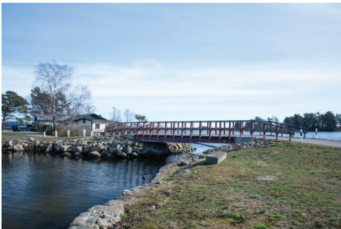
Figur 4 Bron mellan fastlandet och Nötholmen. Även delar av utfyllnaden syns på bilden.
